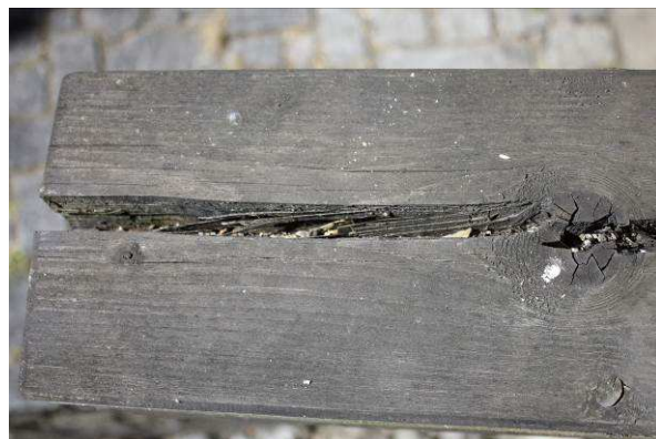
Obrázek 19: zanesení trhlin nečistovými
