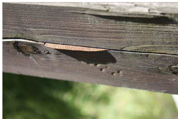
Obrázek 17: plodnice Trámovky plotní
