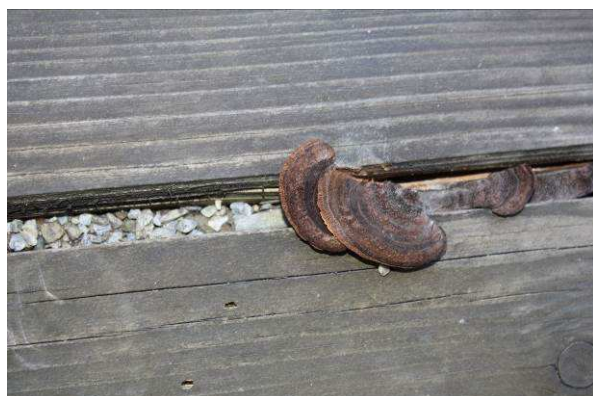
Obrázek 12: výskyt plodnic Trámovky plotní - příčník
