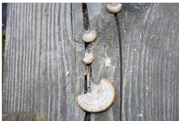
Obrázek 13: výskyt plodnic Trámovky plotní - příčník
