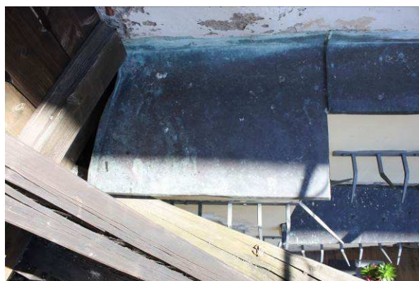
Obrázek 14: nevhodné odvodnění
