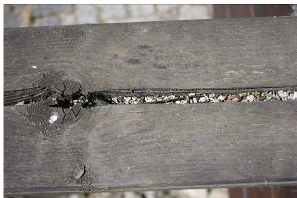
Obrázek 20: zanesení trhlin nečistovými
