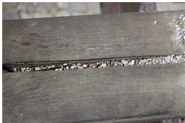
Obrázek 18: zanesení trhlin nečistovými
