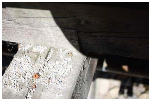
Obrázek 21: zanesení trhlin nečistovými
