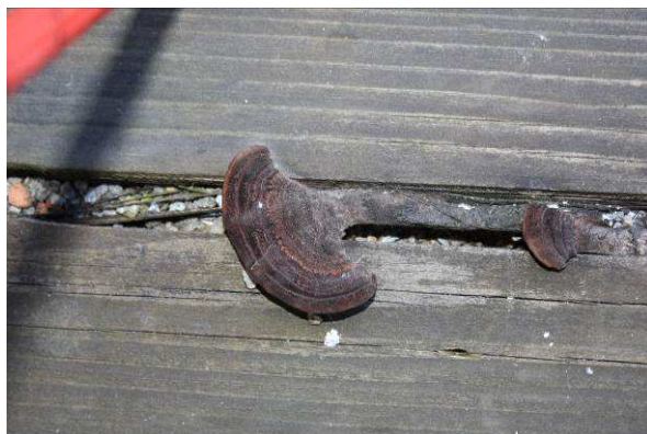
Obrázek 11: výskyt plodnic Trámovky plotní - příčník
