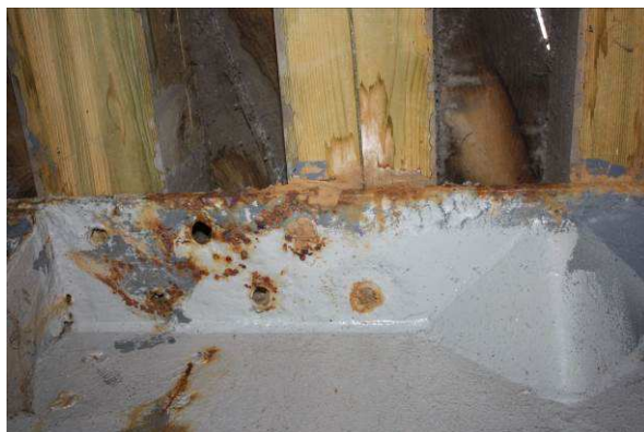
Obrázek 35: osazení příčníků na podélník
