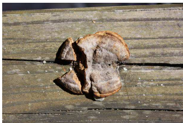
Obrázek 15: plodnice Trámovky plotní
