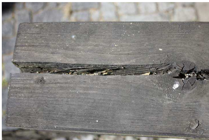
Obrázek 3: fotografie trhliny ve dřevěném příčniku
